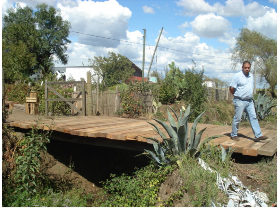
MANTENCION PUENTES Y ALCANTARILLAS
