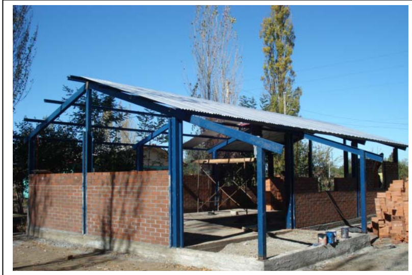
CONSTRUCCION SEDE LAS ESQUINAS
