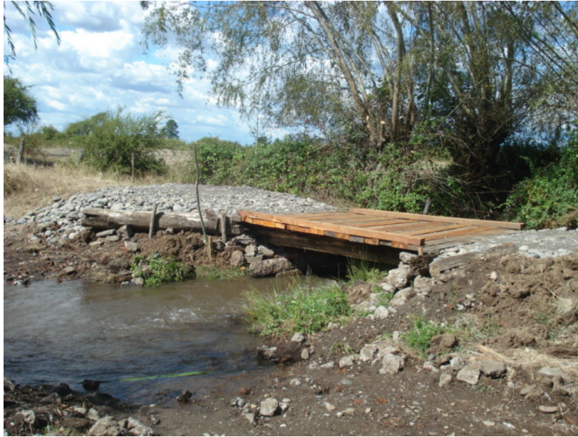
MANTENCION DE PUENTES MENORES Y ALCANTARILLAS.
